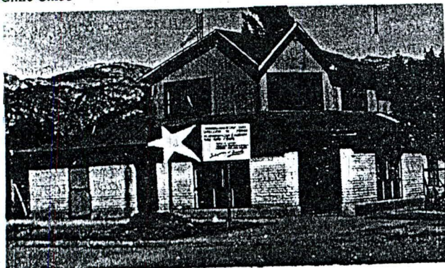
Casa de la Cultura de Chile Chico, Actualmente se ejecutan las obras de mejoramiento en su primera etapa.
