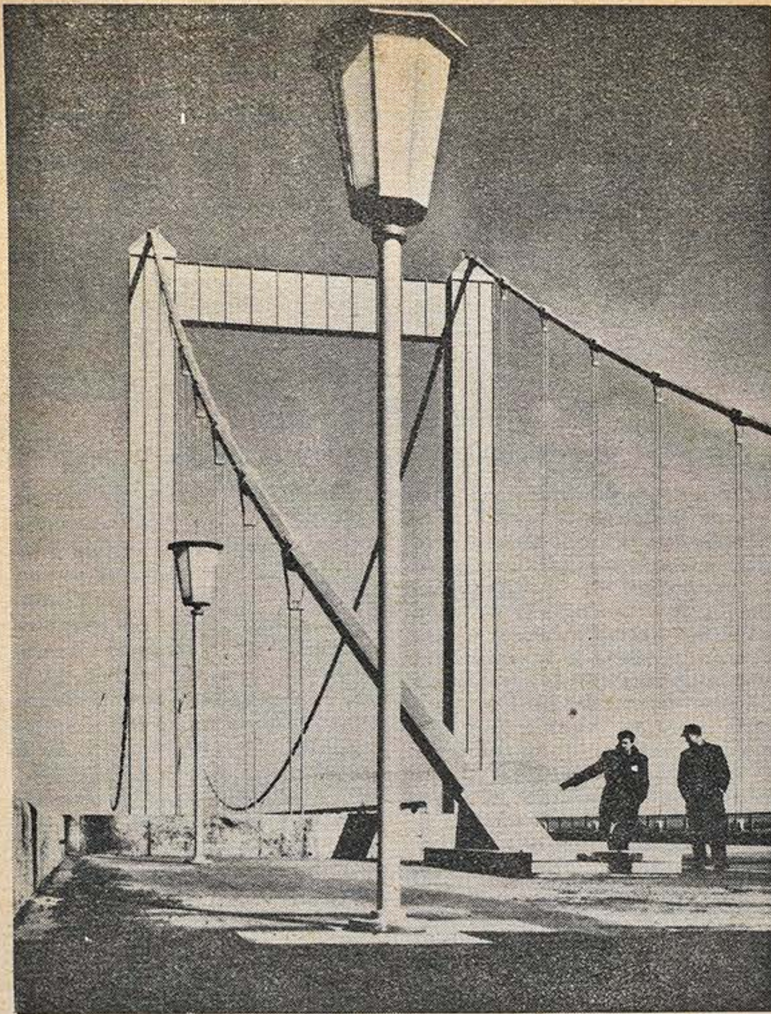
El nuevo puente colgante, de casi 600 metros de longitud, por el que atraviesa el Rin en las proximidades de Colonia una autopista, permite un enlace más rápido con la cuenca del Ruhr, constituyendo el eslabón entre las autopistas del Sur de Alemania y los grandes centros industriales del Norte
