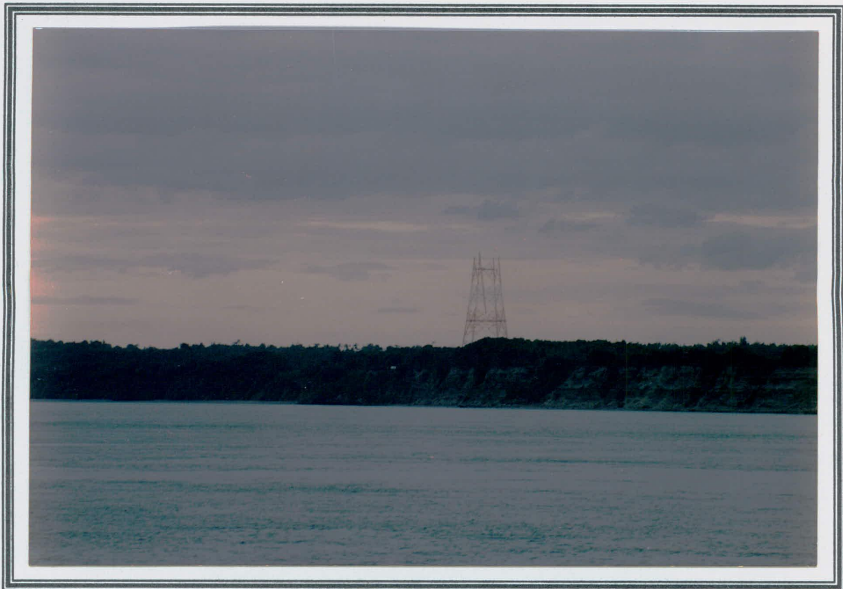
Estado de avance de la torre en el continente.
