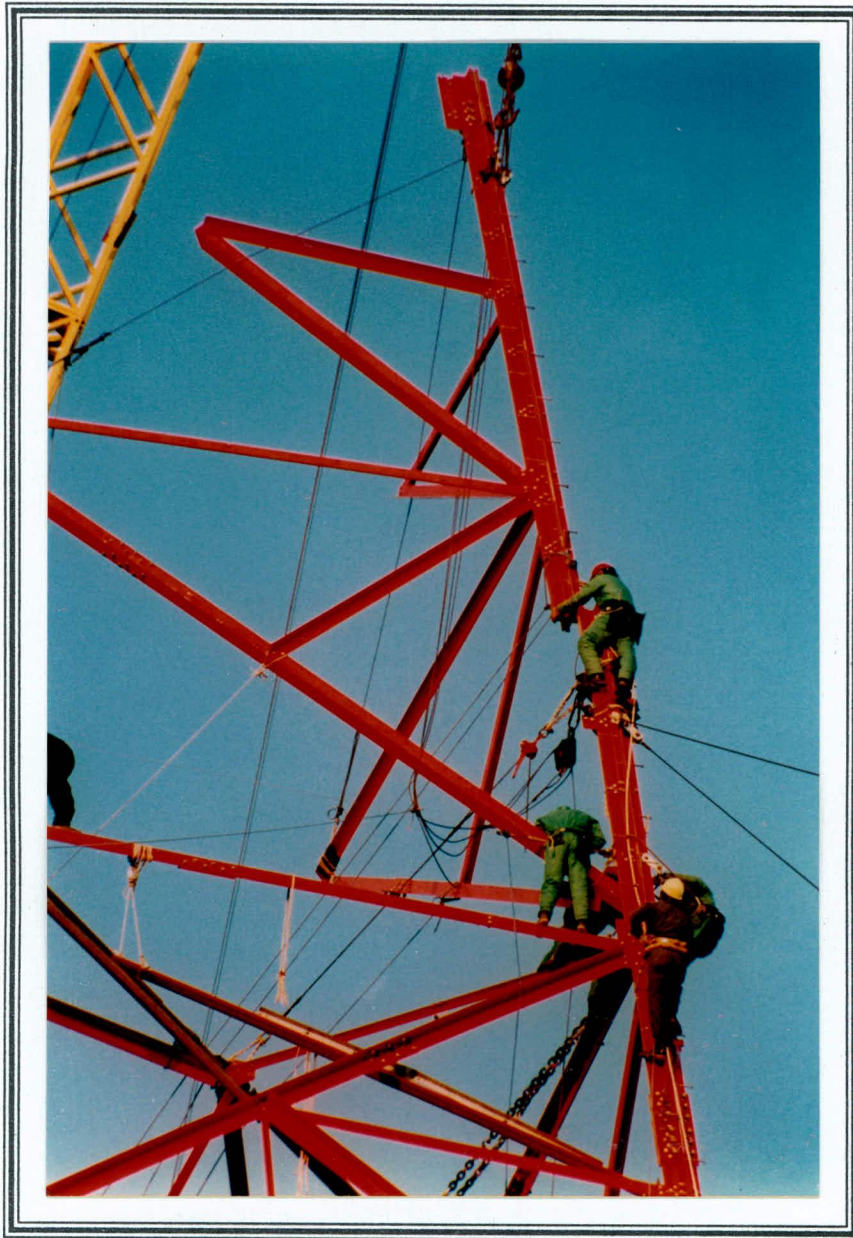
Detalle de los trabajos de montaje de la torre.
