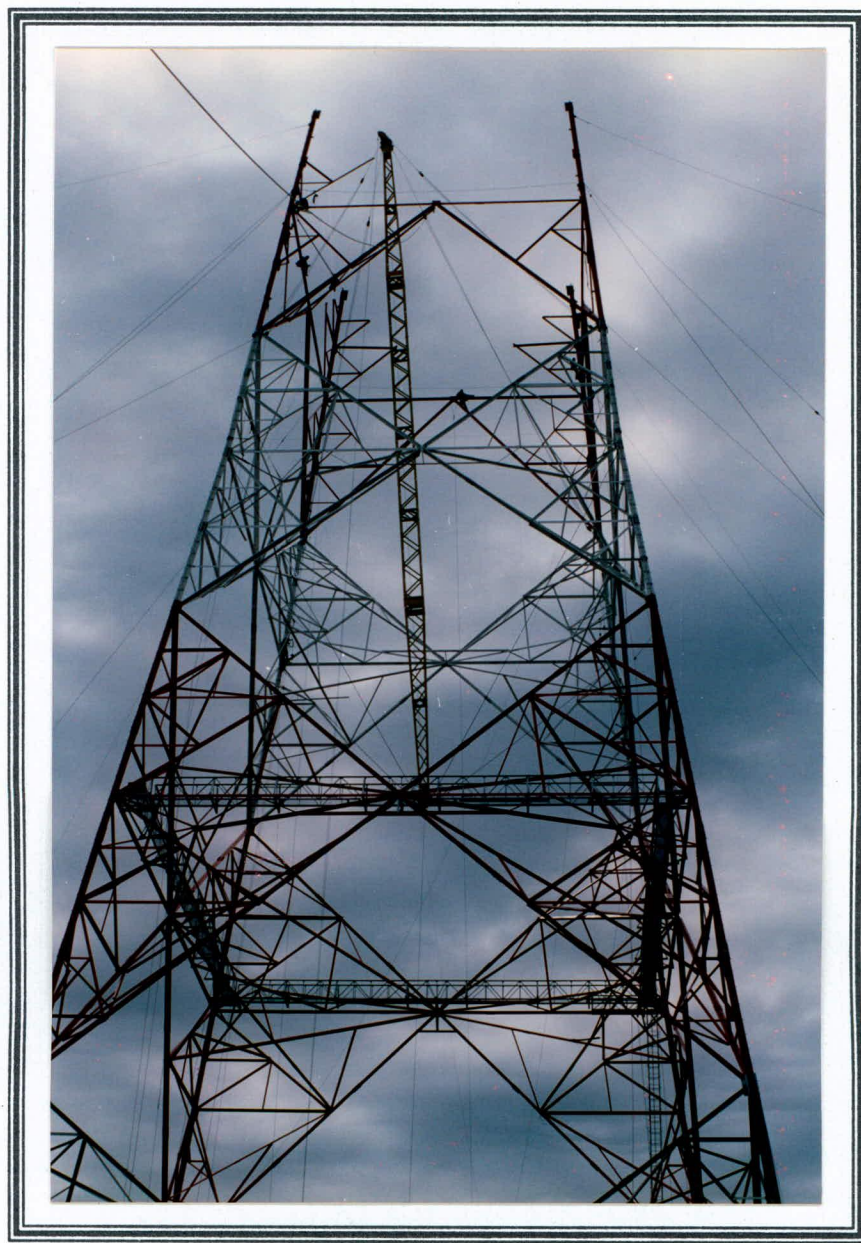
Avance de la construcción de la torre: Altura 90 m.
