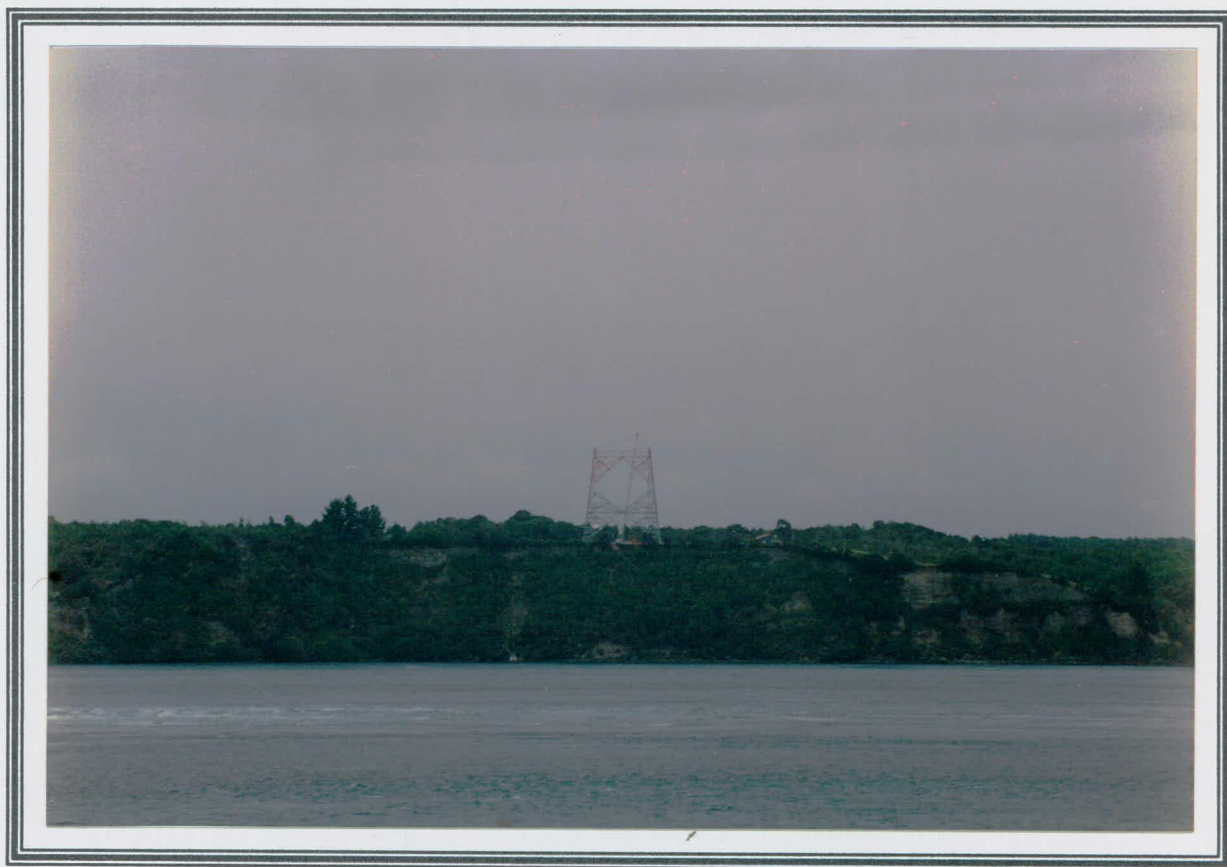
Estado de avance de la torre en la Isla de Chiloé.
