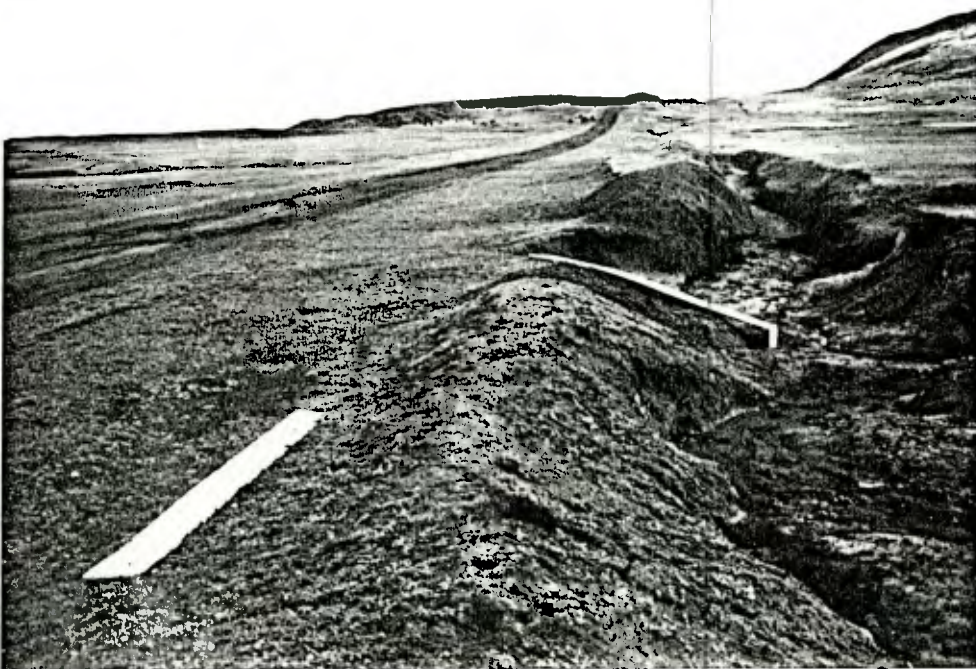
FOTO 4.- Drenajes en aeródromo Robinson Crusoe
