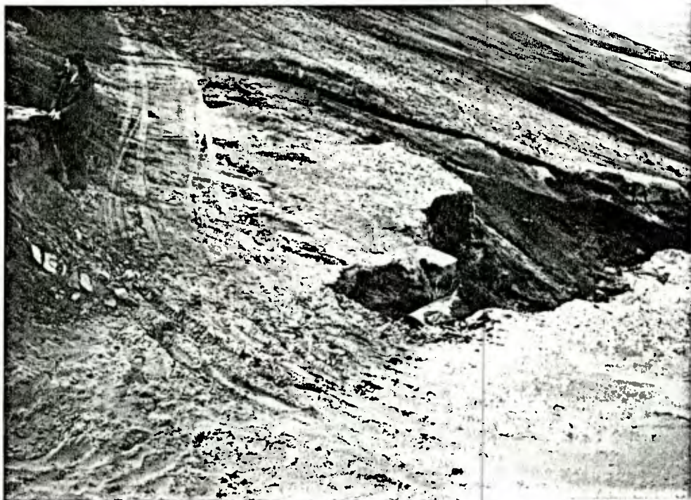
FOTO 2.- Camino al aeródromo Robinson Crusoe
