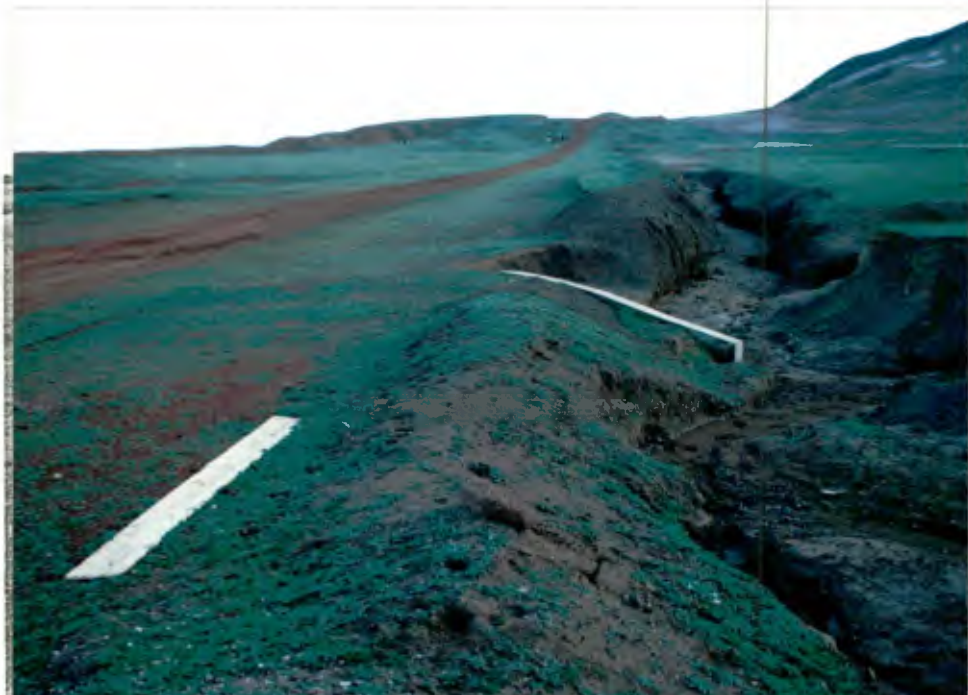
FOTO 4.- Drenajes en aeródromo Robinson Crusoe
